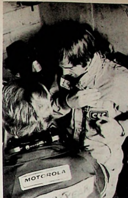
Coureurs en pitsbemanning zijn uitgerust met telefoon/microfoon. Voor de coureur betekent dit dat in zijn helm twee telefoons of mini-luidsprekers zijn ingebouwd evenals een speciale microfoon.
